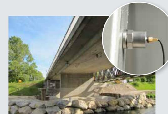
**Brückenmonitoring:** Eine permanente Installation von Sensoren ermöglicht uns eine kontinuierliche Datenaufzeichnung, Datenübertragung, automatisierte Datenauswertung und Messbericht-erstellung sowie die Versendung von Warnungen im Falle von Grenzwertüberschreitungen.
