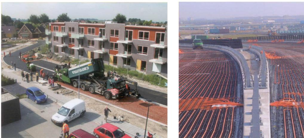
Abbildung 1 (links und rechts): Beispiele für Asphaltkollektoren (Road Energy Systems®, 2007)
