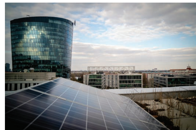
Viertel Zwei PV Anlage © Wien Energie
