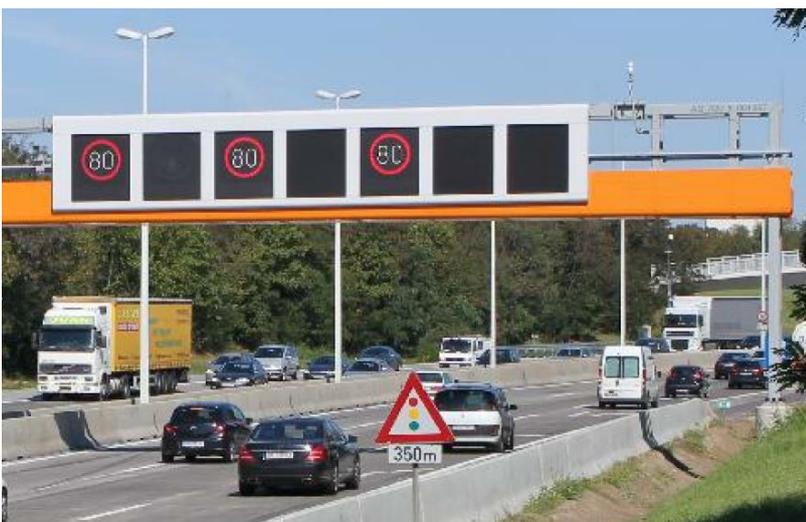
ABB 1. Streckenbeeinflussungsanlage 2.710 mit Photovoltaischer Versorgung, PV SBA 2.710 (Quelle: ASFINAG)
