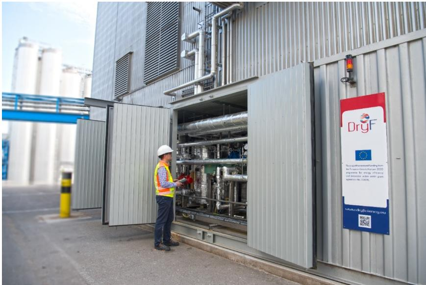
BU: DryFiciency- Hochtemperatur-Wärmepumpen wurden in drei Anwendungsfällen in Betrieb genommen und in industrieller Umgebung getestet. Anlage bei AGRANA Stärke in Pischelsdorf. © AGRANA
