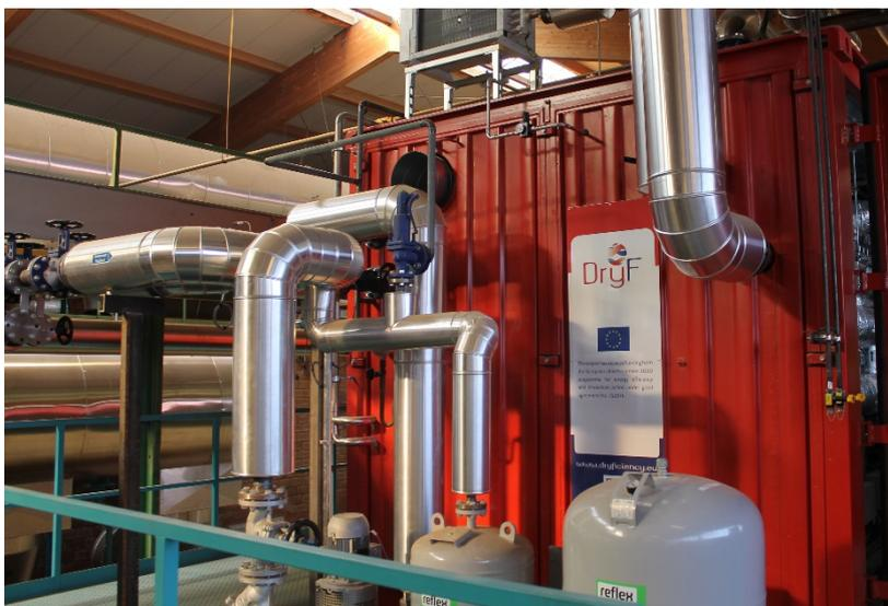
BU: DryFiciency- Hochtemperatur-Wärmepumpen wurden in drei Anwendungsfällen in Betrieb genommen und in industrieller Umgebung getestet. Anlage bei der Wienerberger AG in Uttendorf © AIT / Schneeberger
