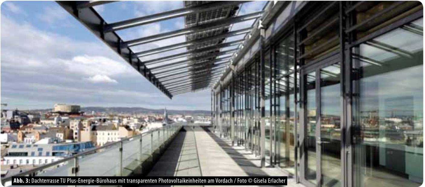
**Abb. 3:** Dachterrasse TU Plus-Energie-Bürohaus mit transparenten Photovoltaikeinheiten am Vordach / Foto © Gisela Erlacher
